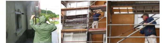
Slika 6. – prikaz visokotlačnega pranja z vodo, na fasadnih površinah
