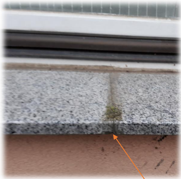
Rega v ravnini Dimenzija A,B min 6 mm A:B = 2:1
