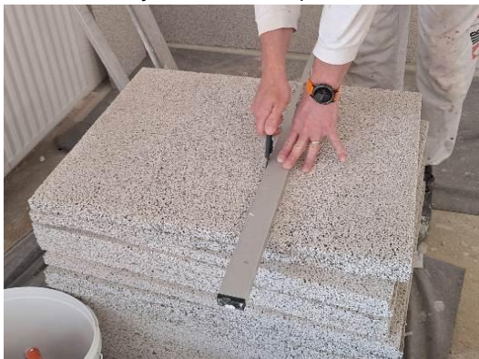
Slika 1: Rezanje Clima control ploča
