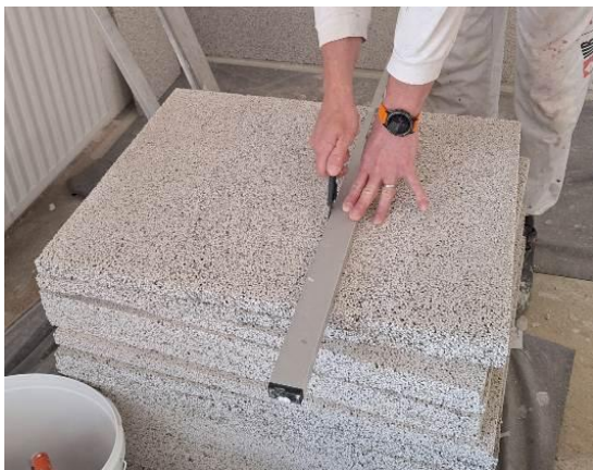
Slika 1: Rezanje Clima control plošč
