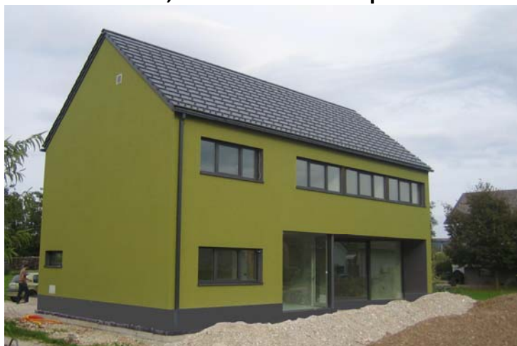
Pasivna hiša, Spodnja Sinica pri Medvodah
