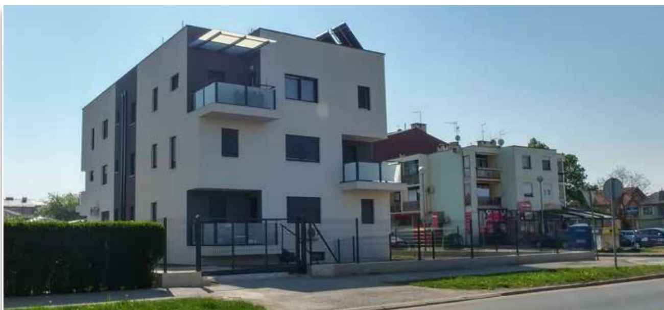
Stambena zgrada Velika Gorica, Jubizol sustav EPS, Jubizol Acrylfinish S, 010C, 050F)
