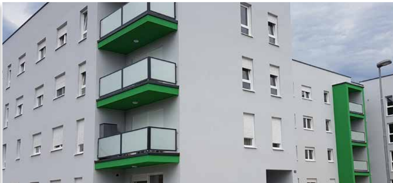
Stambena zgrada Koprivnica, Jubizol sustav MW, Jubizol Unixil finish S 1001)
