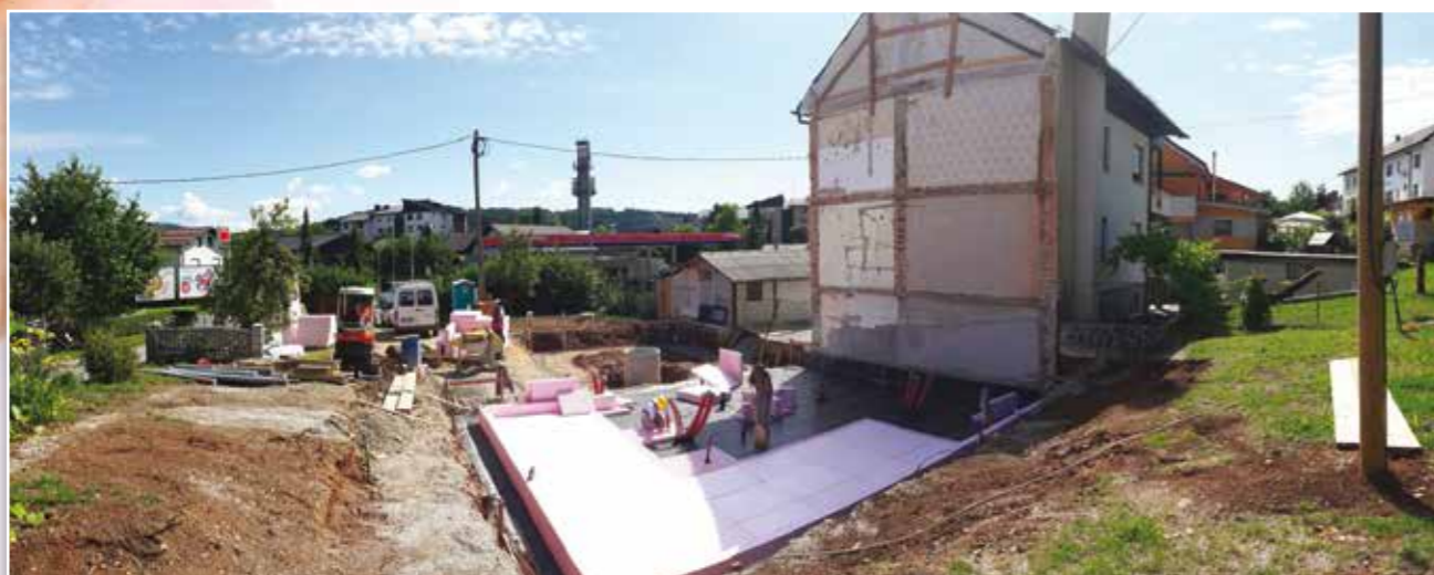
Slika 1-Porušena polovica dvojnog objekta i priprema JUBHome BASE toplinske izolacijske kade
