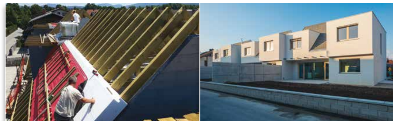
Slika 3-Montaža JUBHome ROOF elemenata i završeni objekt
