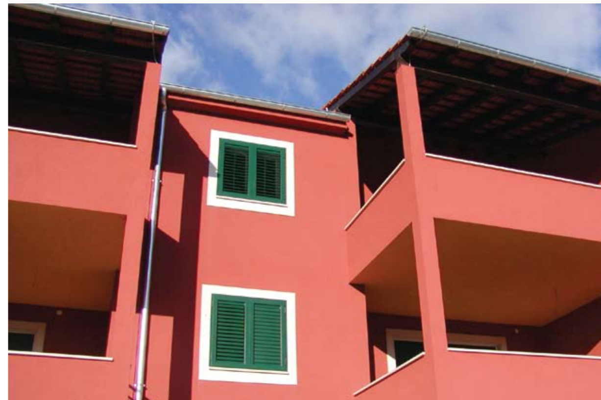
Objekt: stambeni objekt u Vinišiću Materijal: ATG 1,5 mm, nijanse 1210*, i 1080* Vrijeme izvođenja: 2009.
