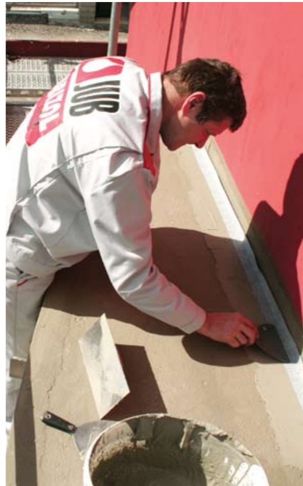
Armiranje spoja vertikalne i horizontalne plohe s elastičnim brtvenim trakama
