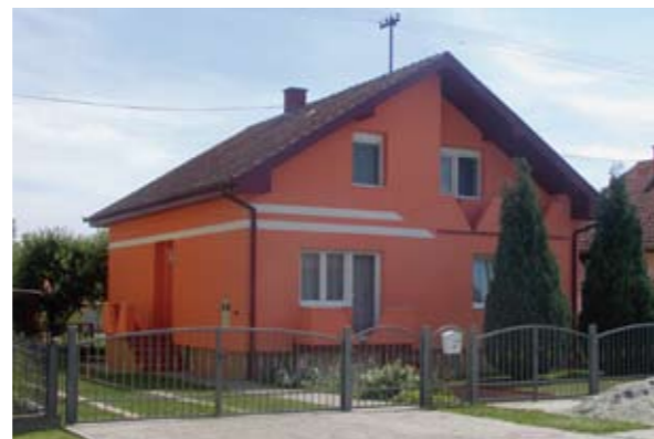
Objekt: obiteljska kuća Beli Manstir Materijal: Jubizol fasada ATZ 2,0 mm, nijansa 5551 Vrijeme izvođenja: 2009.
