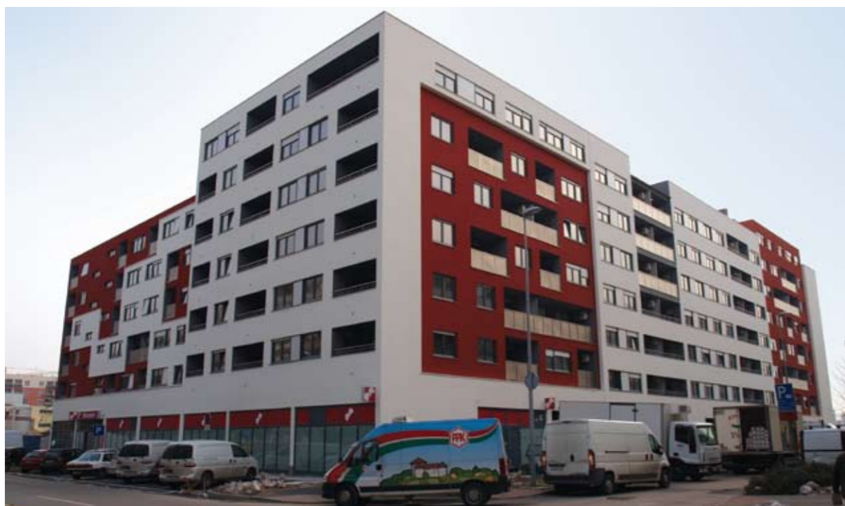
Objekt: stambeno poslovni centar Zvonimir – Zagreb Materijal: Jubizol sustav s ATG 2,0 mm, nijanse 5581, i 1001 Vrijeme izvođenja: 2009.
