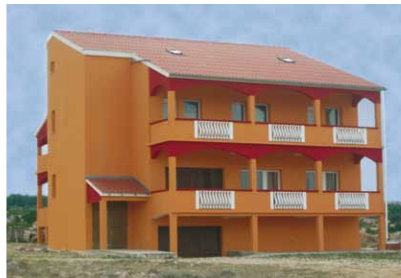
Objekt: stambeni objekt Ražanac Materijal: Jubizol EPS, ATG 2.0 nijanse 2152 i 5581 Vrijeme izvođenja: 2010.
