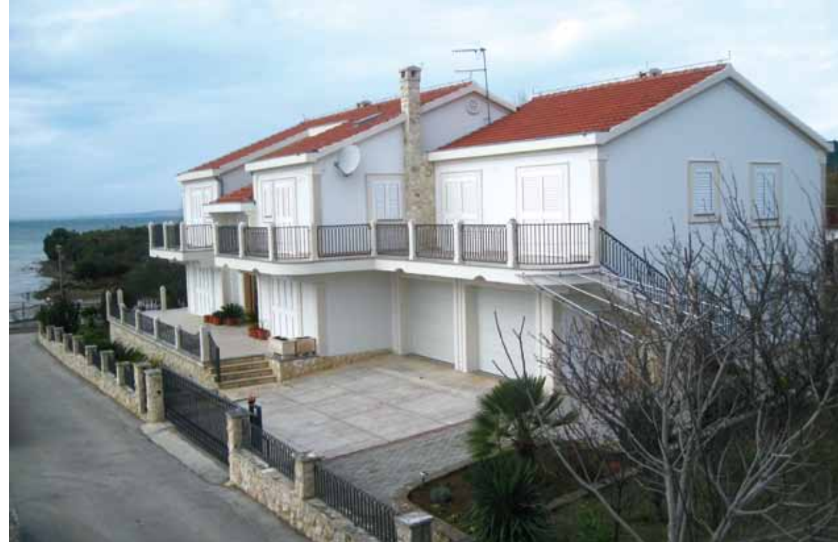
objekt: privatna kuća Zadar - Ljubač materijal: SNG 1.5 bijela, okviri oko prozora i istaci ATG 1.0 nijansa 1085 vrijeme izvođenja: 2010
