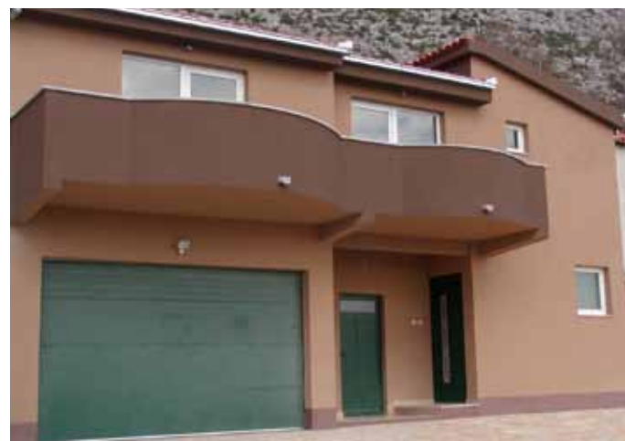
Objekt: privatna kuća Split Materijal: ATG 2.0, nijansa 1122 Vrijeme izvođenja: 2010.
