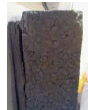
Prikaz odvajanja izolacijske ploče od ljepila odnosno podloge
