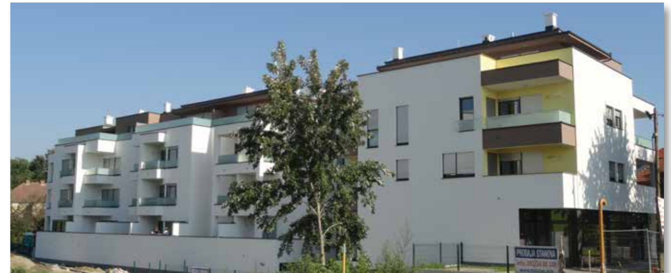
Stambena zgrada Novalja, Jubizol sustav, Nanoxil G 4642
