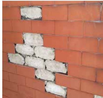
Slika 1: Zatečeno stanje na objektu
