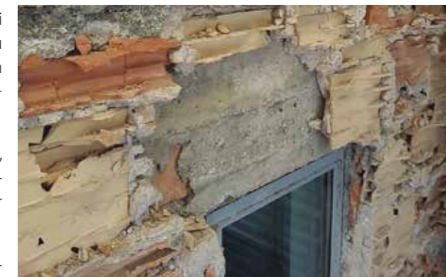
Slika 4: Uklanjanje klinkera i porolitne obloge do zdrave podloge odnosno nosivog zida
